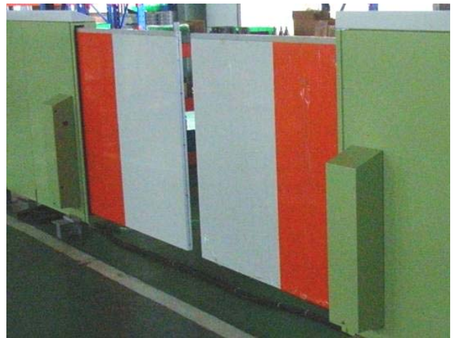
図3. 駅ホーム柵の外観
