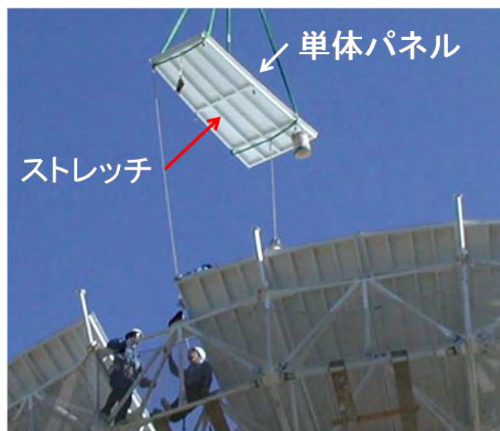
図 12. 1 枚の反射パネルの構造 (撮影: 国立天文台 宮地竹史氏)
